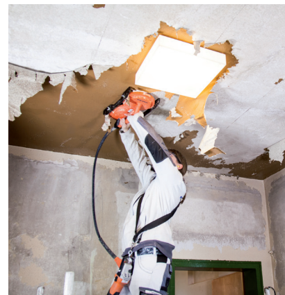
Stripping av tapet
