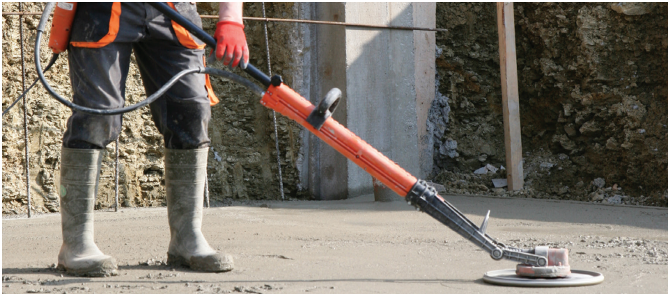
Jevner ut fersk betong
