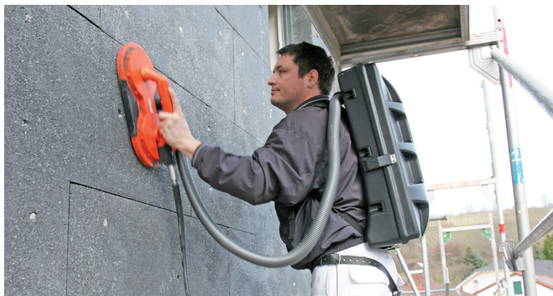
Støvfritt arbeid på stillas
