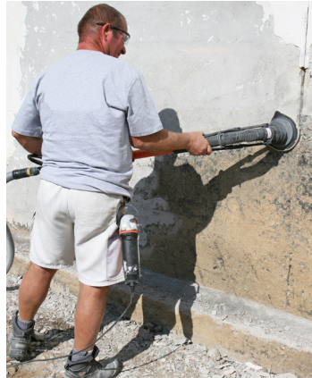
Sliping av bitumenbelegg med PCD-slipekive
