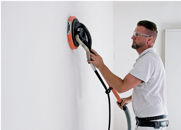
Rask og effektiv sliping av store overflater
