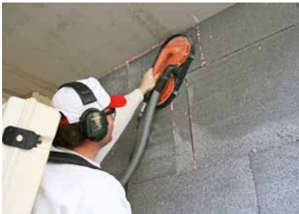
Sliping av EIFS og ETICS isolasjonsplater
