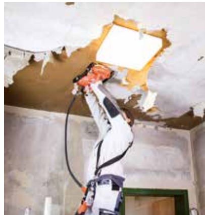
Stripping av tapet
