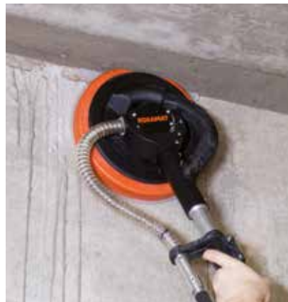
Sliping av betong ujevnheter
