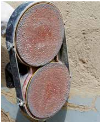
Rengjøring av fasader
