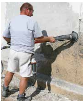
Sliping av bitumenbelegg med PCD-slipekive
