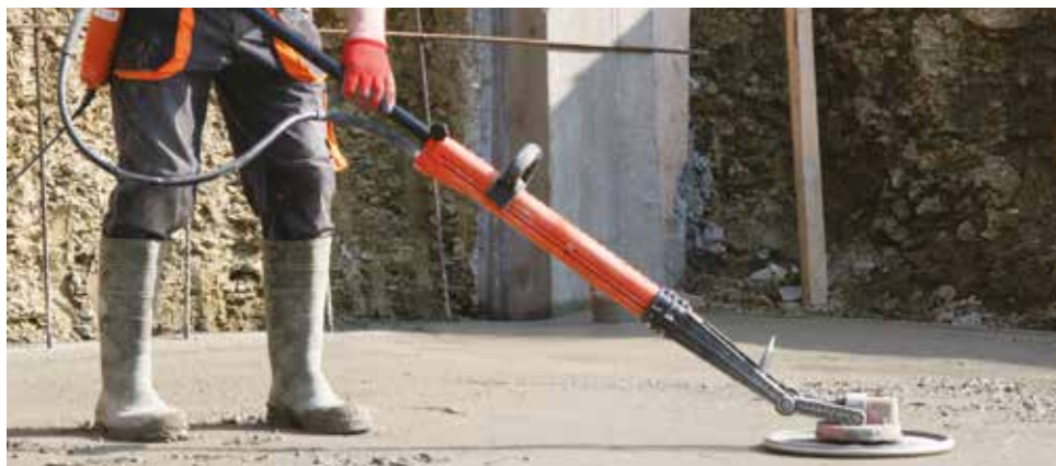
Jevner ut fersk betong
